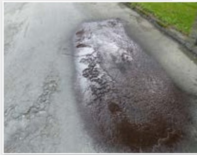
Aufbringen einer Spezialemulsion als Haftbrücke
