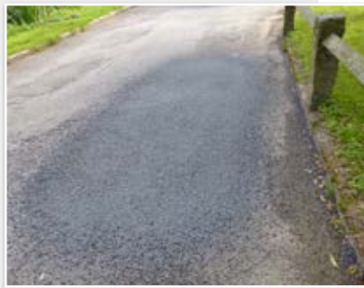
Abdecken der Schadstellen mit Edelsplitt
