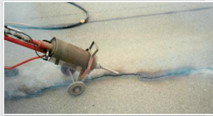
Das Reinigen der Risse und das Anschmelzen der Rissflanken mit einer Heißpressluftlanze.
