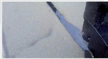
Der Riss wird mit einem dauerelastischen Fugenvergussmaterial vergossen.
