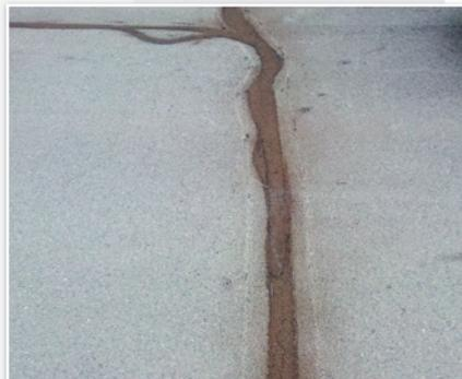
Das Ergebnis einer Rissesanierung im HPS-Verfahren.
